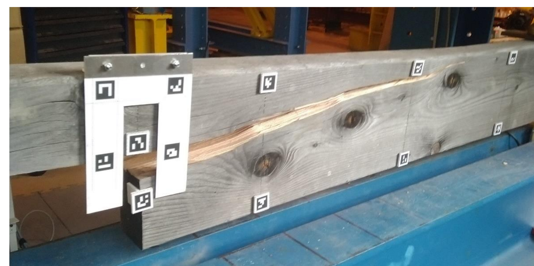
Fig. 7 : Rupture de la poutre
