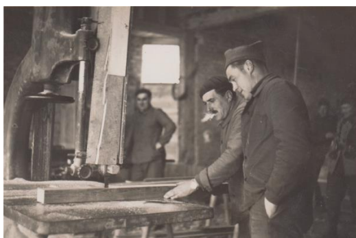
Fig. 4 : sciage d'une pièce de bois à l'aide d'une scie à ruban – Photographie anonyme, 1946
