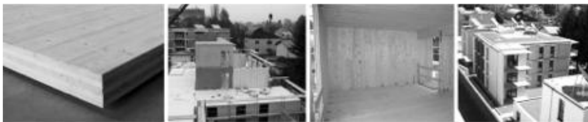
Fig. 1 : Panneau de CLT et utilisation dans une structure de génie civil (Brandner et al 2016).
