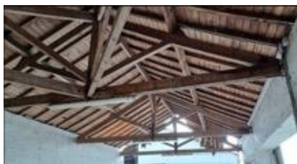
Fig. 3 : Vue Général de la charpente du local de l'hôpital Bagatelle
