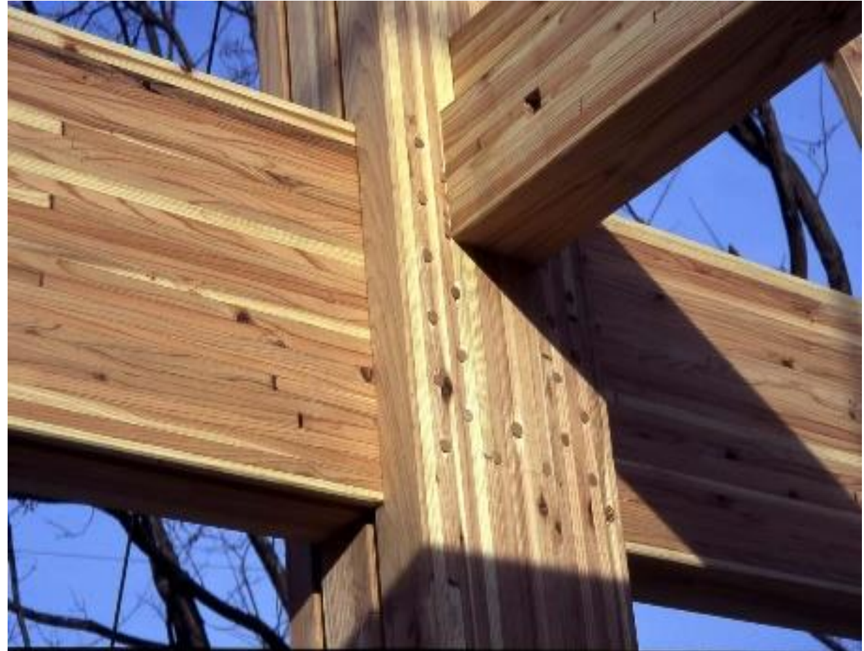
Assemblage par tourillons en bois densifié
