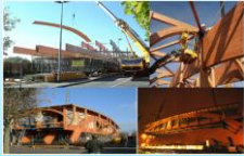
Passerelle de Vaires-sur-Marne [CNDB 2005]
