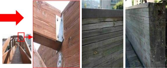
Fissures, délaminations d'une passerelle piétonne sur le Sichon à vichy
