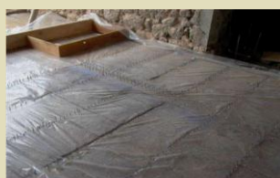
FIG. 1 – Plancher mixte bois-béton.
